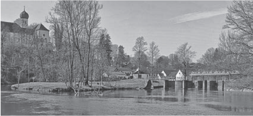
Ausleitung des überschüssigen Wassers am Beuerberger Wehr in den 10,6 km langen Loisach-Isar-Kanal. Foto: Christian Buchner
