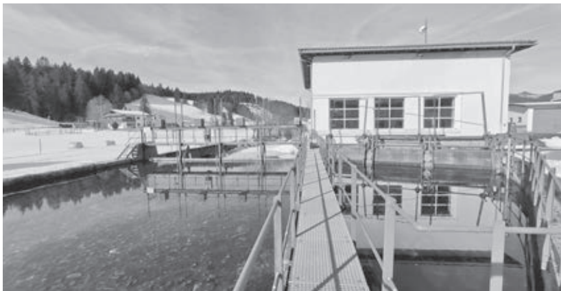
Das Pumpwerk in Achenkirch pumpt das Wasser vom Bett der Seeache hoch zum Ampelsbachkanal. Foto: Christian Buchner
