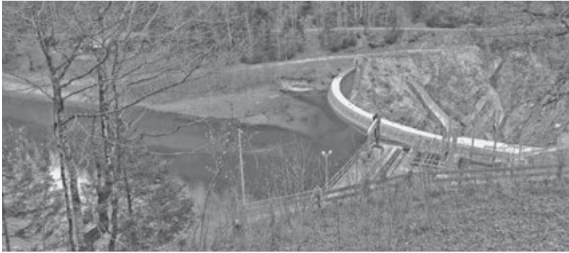
Das Wehr im Bächental unterhalb des Zusammenflusses von Baumgartenbach und Plumbach leitet deren Wasser ab in den Achensee. Foto: Christian Buchner
