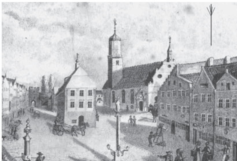
Abb. 5: Ausschnitt aus einer Lithographie des Marienplatzes von Franz Stempf (1831), mit Blitzableitern auf Mariae Himmelfahrt (Privatbesitz). Die horizontalen Spitzen des Hemmer'schen Ableiters zeigen in modernisierter Form schräg nach oben, wie aus der eingezeichneten Ergänzung zu ersehen.
