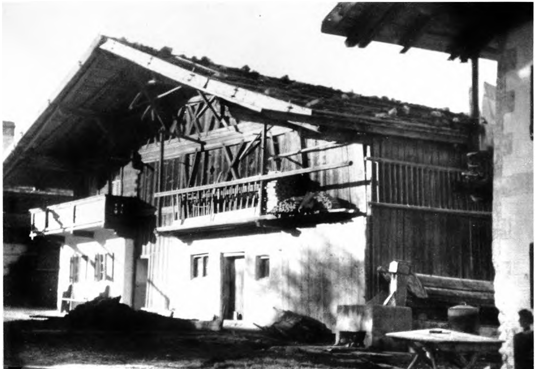
Abb. 4 Obergrainau, Zugspitzstraße 5 zum Franzen (Südseite); erbaut 2. Hälfte des 18. Jahrhunderts
