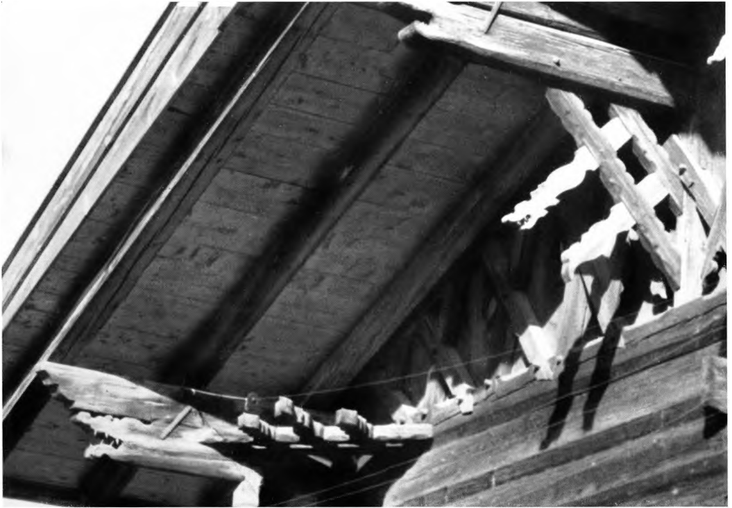
Abb. 3 Garmisch, Zugspitzstraße 3; Teilansicht des Ziergiebels, erbaut Ende des 17. Jahrhunderts
