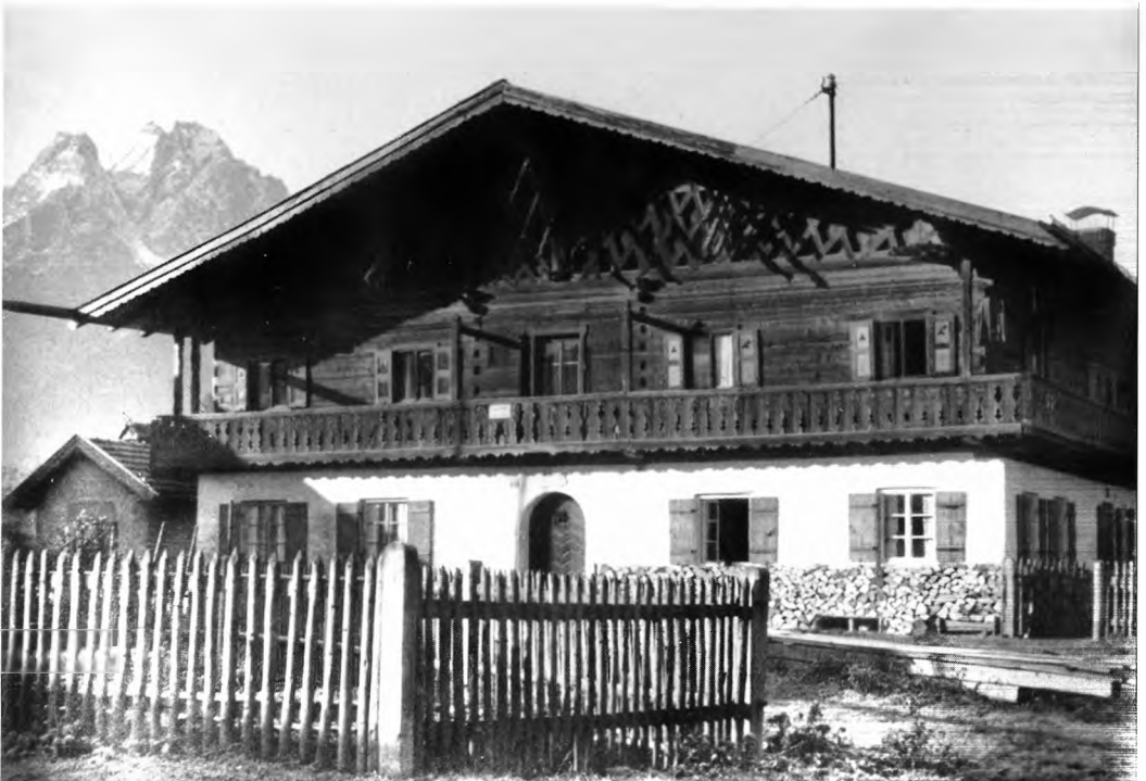
Abb. 2 Garmisch, Zugspitzstraße 21 — 21 a — 23 (Ost-Ansicht)
